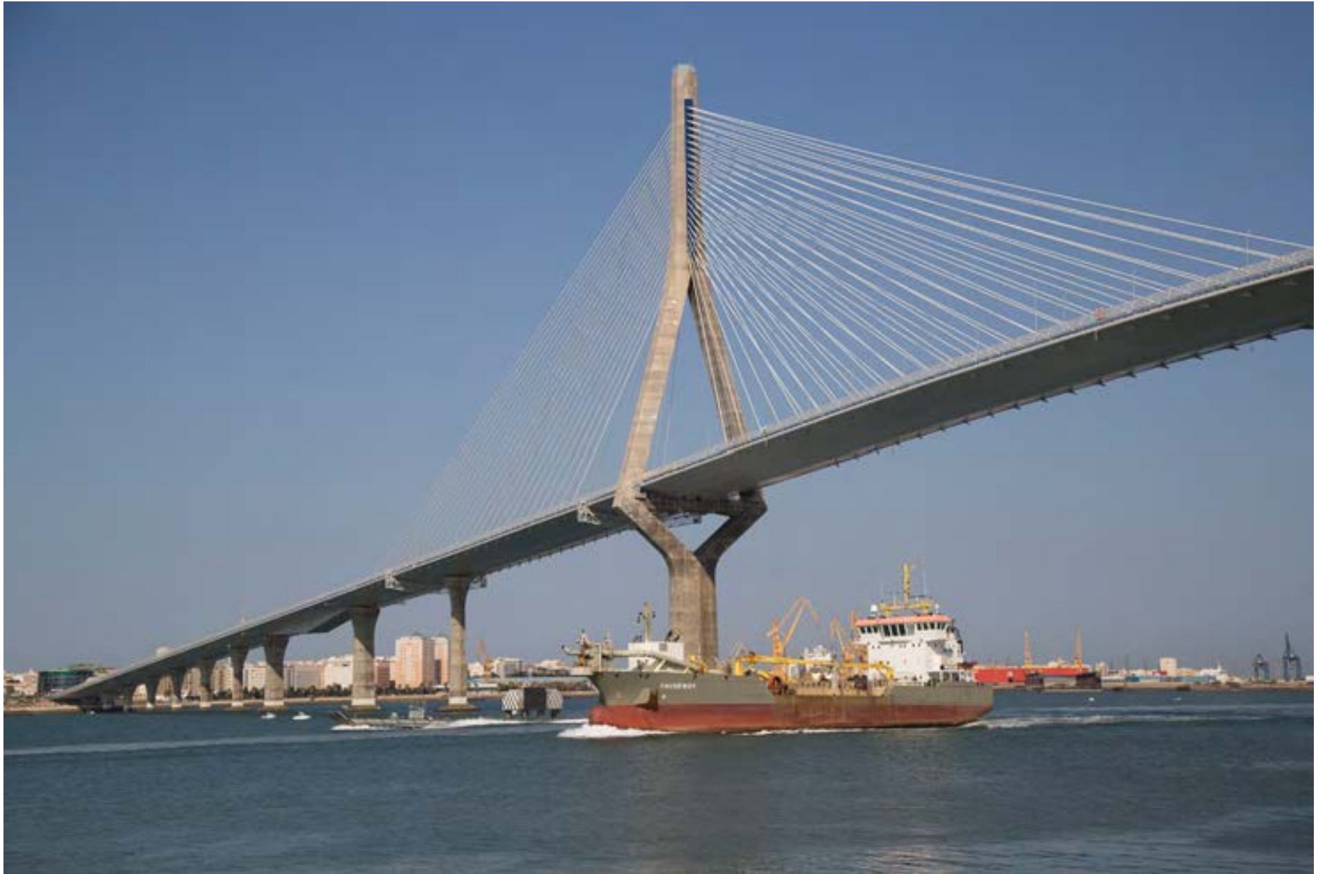
Draga Causeway, que realizó los trabajos de dragado de las dársenas de La Cabezuela y de Zona Franca.
