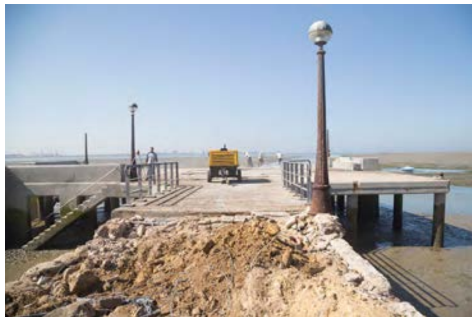
Obras en La Puntilla, Puerto Real.
