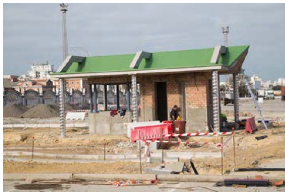
Obras de los nuevos controles de acceso al muelle de Cádiz.
